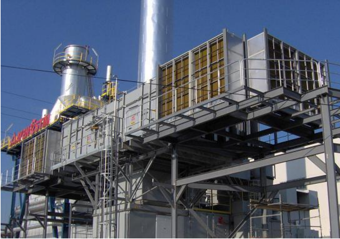
Resim.2- Türbin Giriş Havası Soğutma Ünitesi Uygulama Örneği
