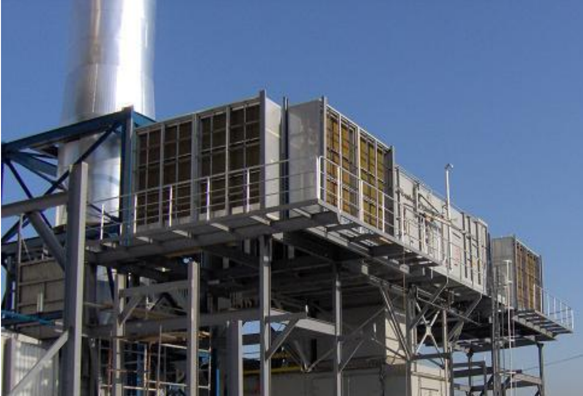
Resim 3- Türbin Giriş Havası Soğutma Ünitesi Uygulama Örneği
