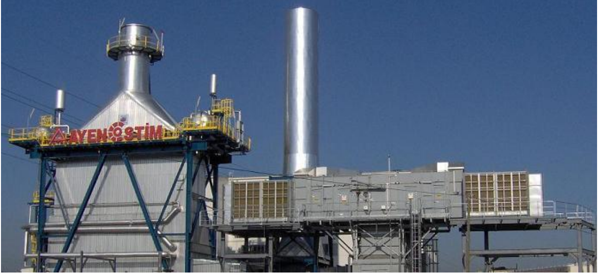
Resim.1- Türbin Giriş Havaşı Soğutma Ünitesi Uygulama Örneği
