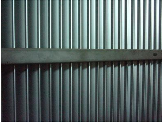
Şekil 14.1: Damla tutucu detayı- sağ ve sol taraftan
