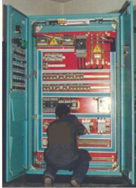
Resim 3.4: Kumanda panosu son kontrollerini yapan teknisyen
