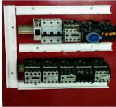
Resim 3.2: Kumanda elemanlarının yerleştirilebileceği raylı pano
