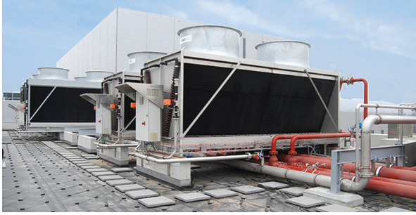
Şekil 2.29 Kendinden boşalmalı (self-drain) kuru soğutucu (Kaynak: Jaeggi)
