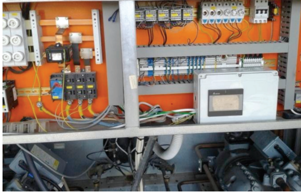
Şekil 3.8 Güç analizörü bağlantısı ve akım trafosu
