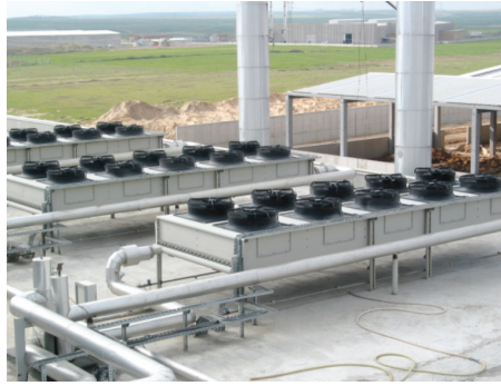
Şekil 2.33 Kuru soğutucu ünite uygulaması (Kaynak: Friterm)
